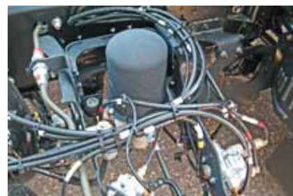
В пневмосистеме применяются преимущественно пластиковые трубки
